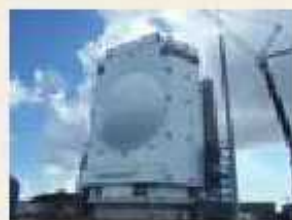
レーダー施設
