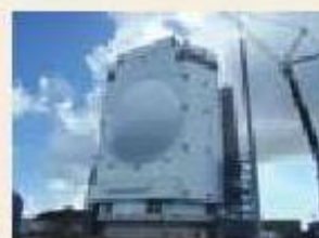
レーダー施設
