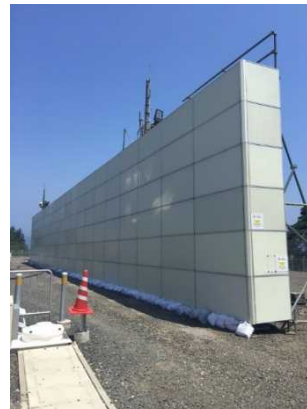
発電機周囲の既設防音パネルの強化
