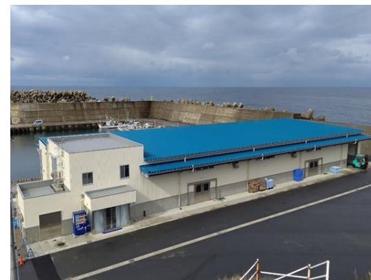
間人漁港荷捌所等整備事業(基金)
