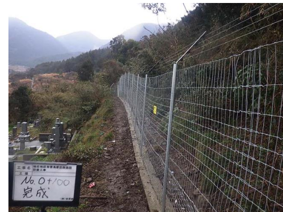
袖志・尾和地区有害鳥獣 防除施設整備事業
