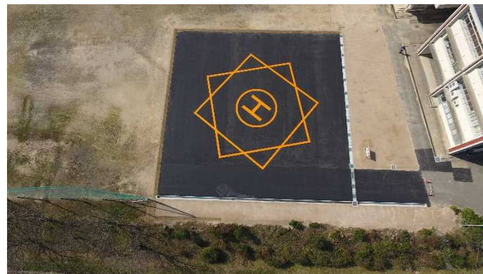
救難施設(ヘリポート)【旧宇川中学校グラウンド】 (令和2年3月25日完成)
