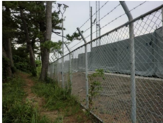
防音パネル(九品寺側境界付近)の設置
