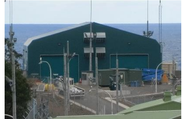
レーダーテントの騒音対策工事の実施
