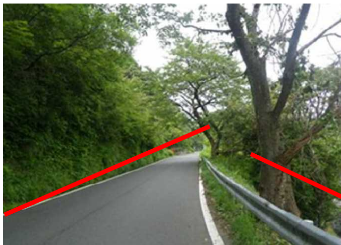
国道178号線(カマヤ工区)
