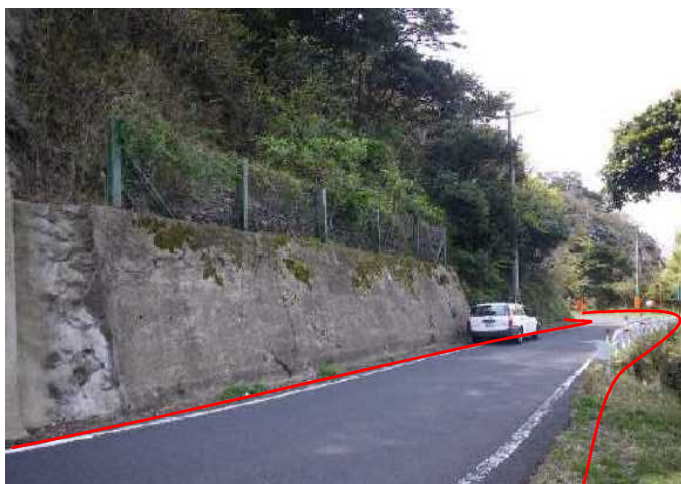
国道178号線(袖志工区)
