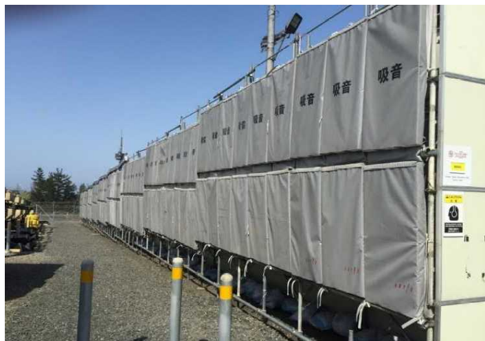
防音パネル・吸音パッド(平成26年12月設置)
