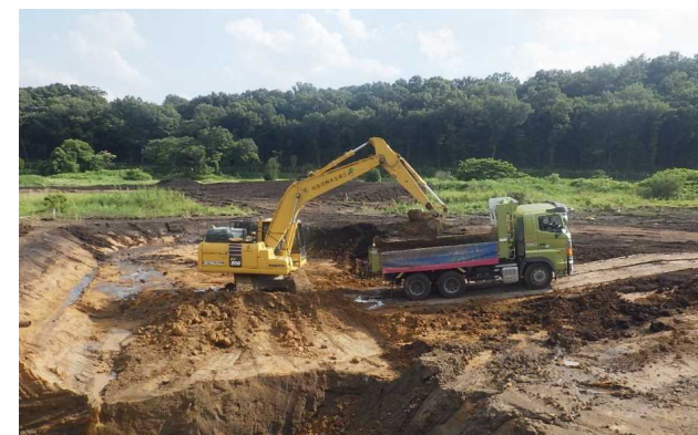
敷地造成工事(イメージ)
