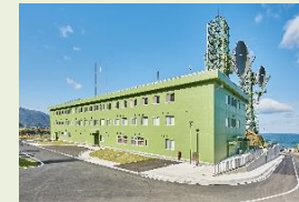
経ヶ岬隊庁舎新設
