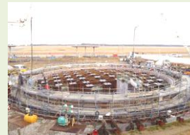
小松燃料施設（建設中の写真）
