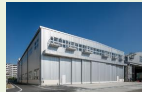
八尾格納庫新設
