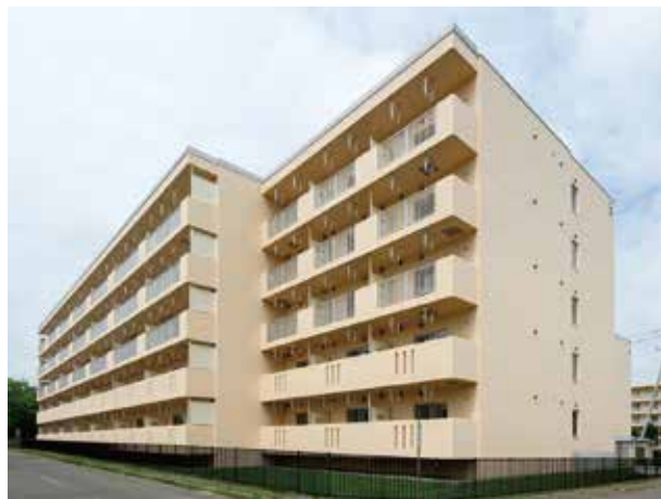
工事区域全景
