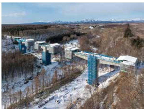
工事区域全景
