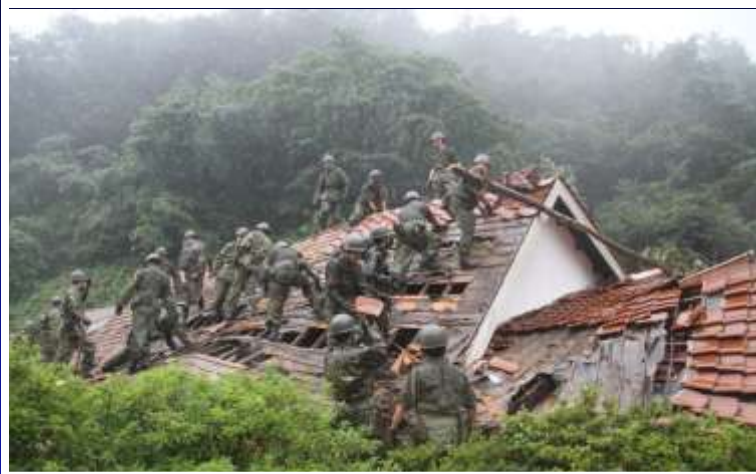
倒壊家屋内の捜索
