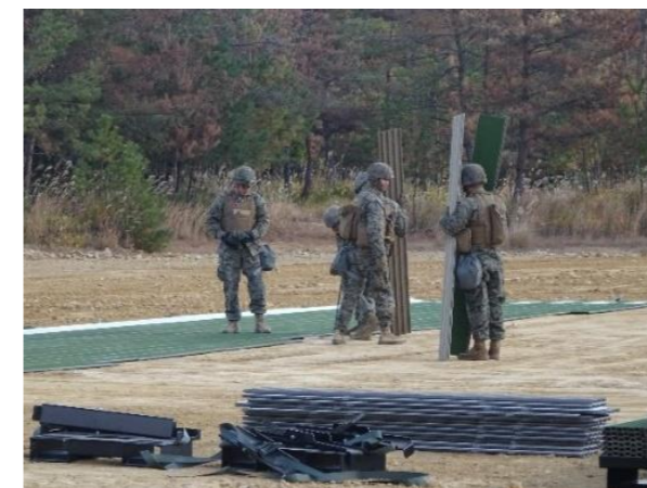
ヘリパッド用マット敷設訓練
