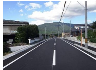
道路改修事業（周辺環境整備課）
