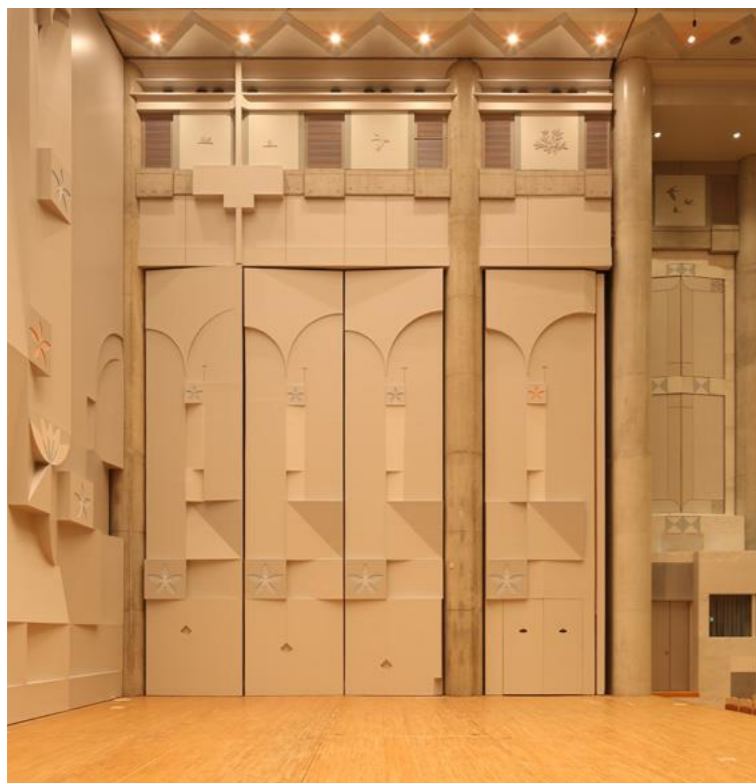
音響反射板の改修
