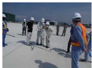
完成検査風景
