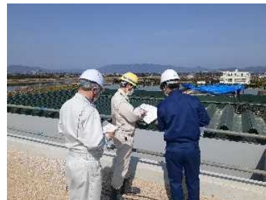
工事監督官現場確認風景
