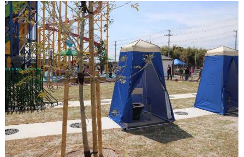
マンホールトイレ
