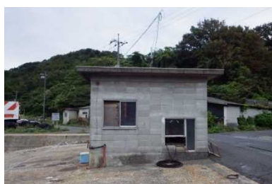
【整備前】巻揚施設（ウインチ小屋）※
