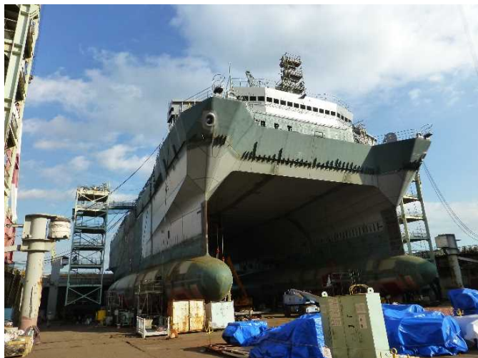
令和元年11月作業中
