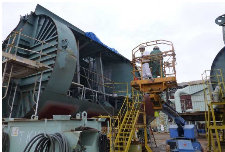
令和元年7月作業中
