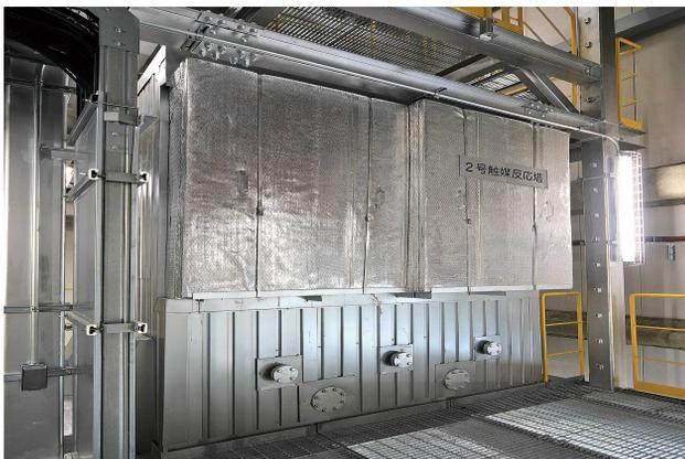
排ガスの有害物質を抑制する触媒反応塔
