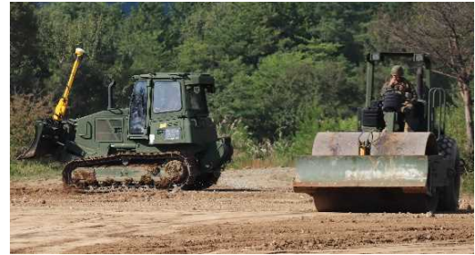
ヘリパッド敷設訓練のため整地を行う重機
