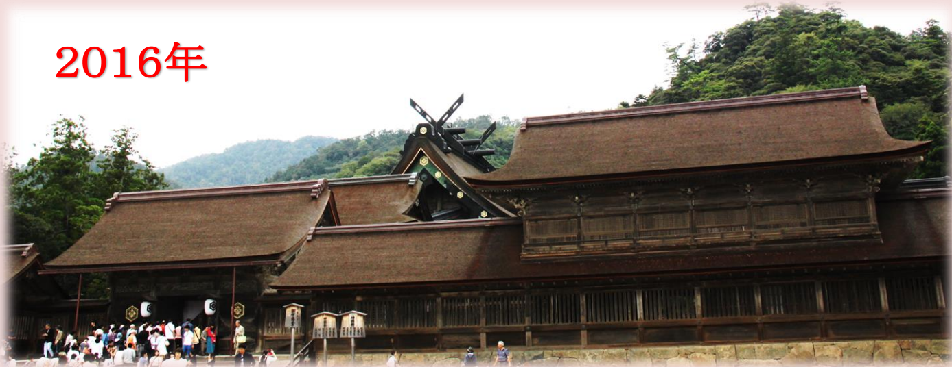
出雲大社「御本殿」 (平成25年に60年ぶりの大遷宮が行われ、大屋根のふき替えが行われました)
