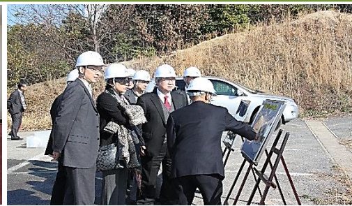
愛宕山敷地造成工事 現場視察
