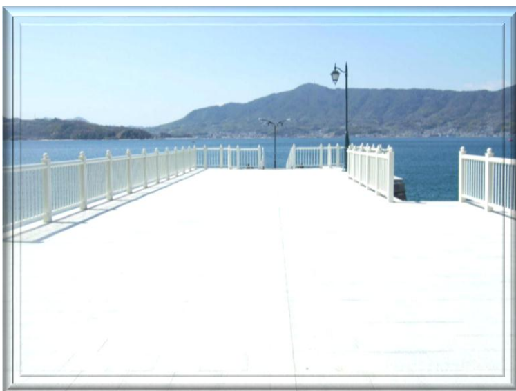
海上自衛隊第1術科学校 (護岸改修工事)
