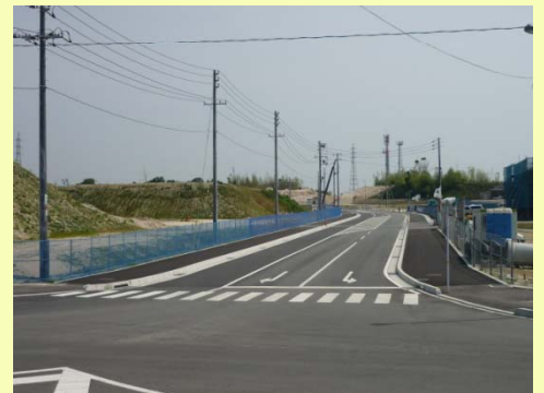
道路改良舗装(岩国市)
