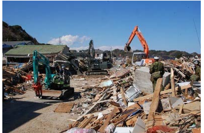
瓦礫の除去(いわき市第8普通科連隊、第13施設中隊)
