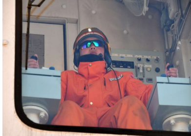
クレーンを操縦する中越3曹
