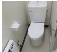
トイレの設置 (女性用)
