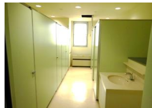
トイレの増設
