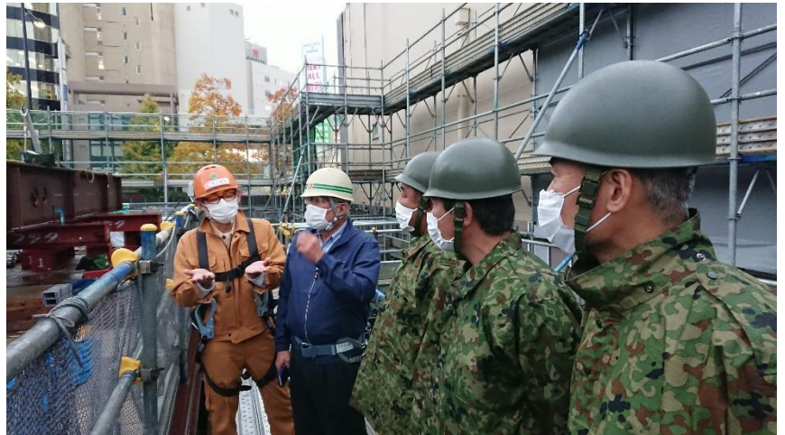
【9日 (株)岡部工務店 様の日本生命ビル施工現場を見学する隊員】
