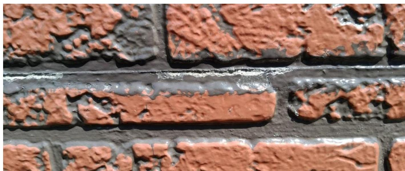
さて、こちらは我が家の外壁の拡大写真ですが、約19年が経過して剥がれたりヒビが入って傷んでいたもので、最初は外壁の補修・塗装を行いました。
