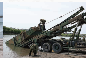
浮橋架設訓練
