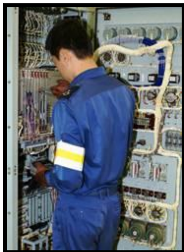
調子はどうかな？ (機器の保守整備)
