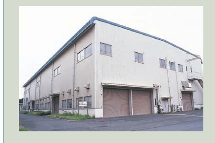
理工学総合実験棟 ■A～E棟まであり、大型の実験装置や実習工場などがあります。
