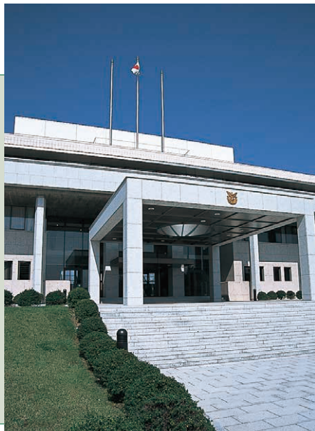
本部庁舎 ■ 正門をくぐると、正面には本部庁舎が見えます。
