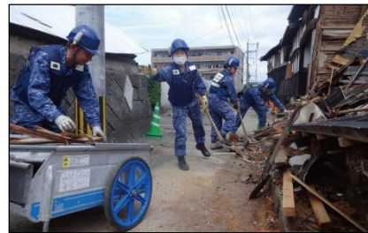
瓦礫などの撤去作業
