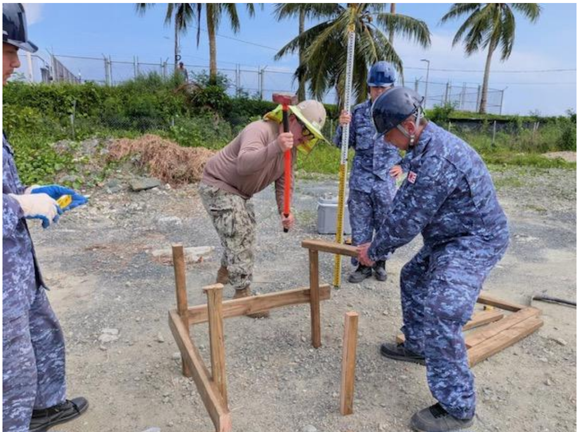
施設補修訓練
