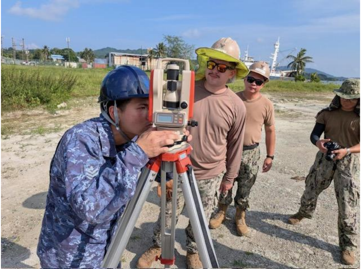
施設補修訓練
