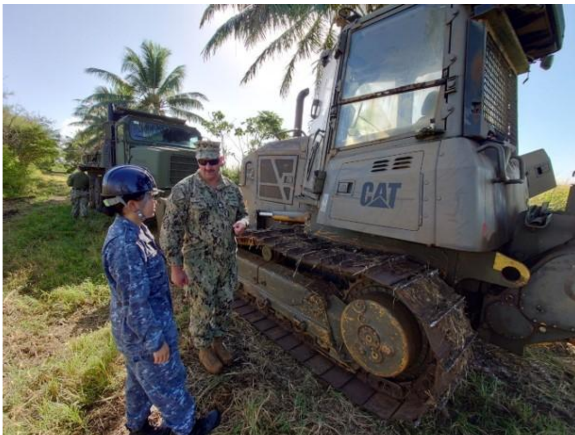
施設補修訓練
