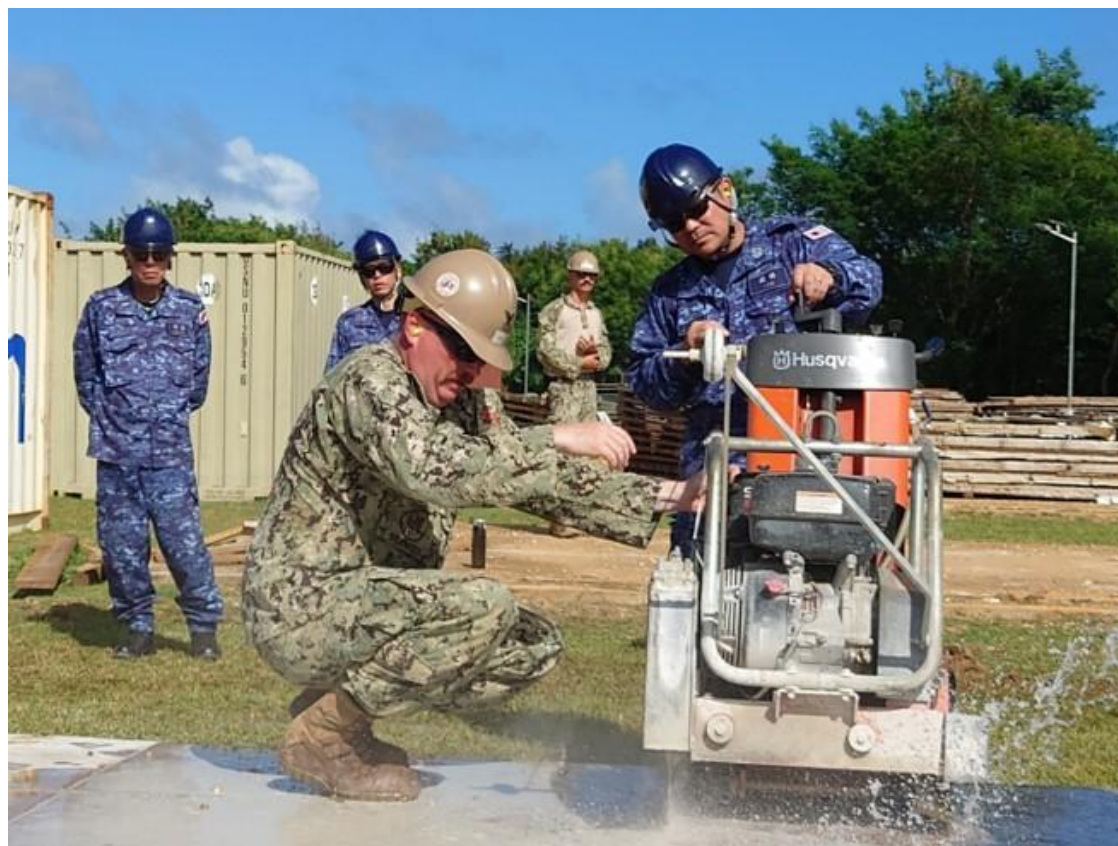
施設補修訓練
