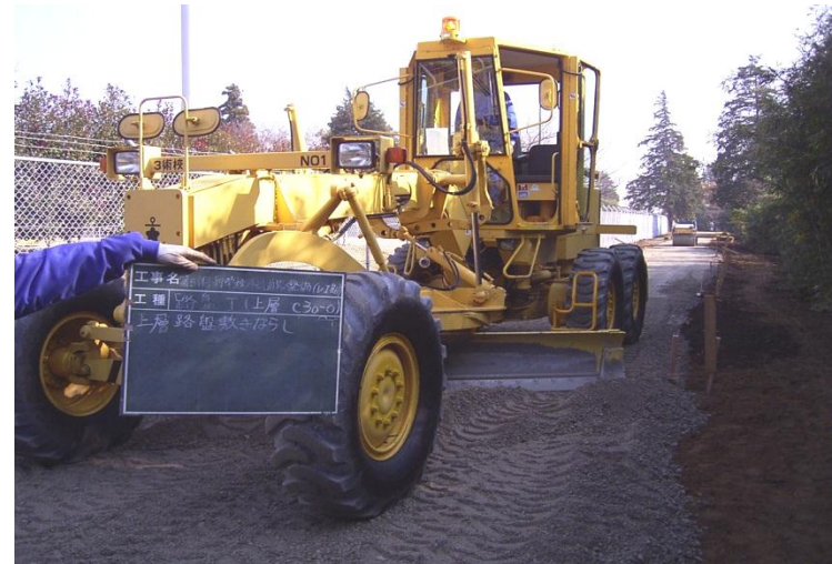
(土木工事施工中)
