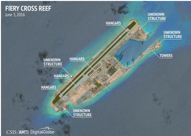
図2：ファイアリークロス礁埋立て工事の状況
