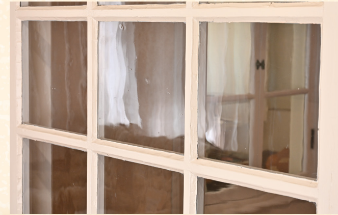
窓ガラス(一部新しいものになっています)
