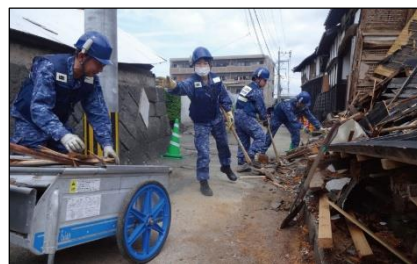
瓦礫などの撤去作業
