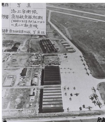
S31年の格納庫及び駐機場
