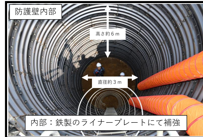
現場の状況②「防護壁の内部」
