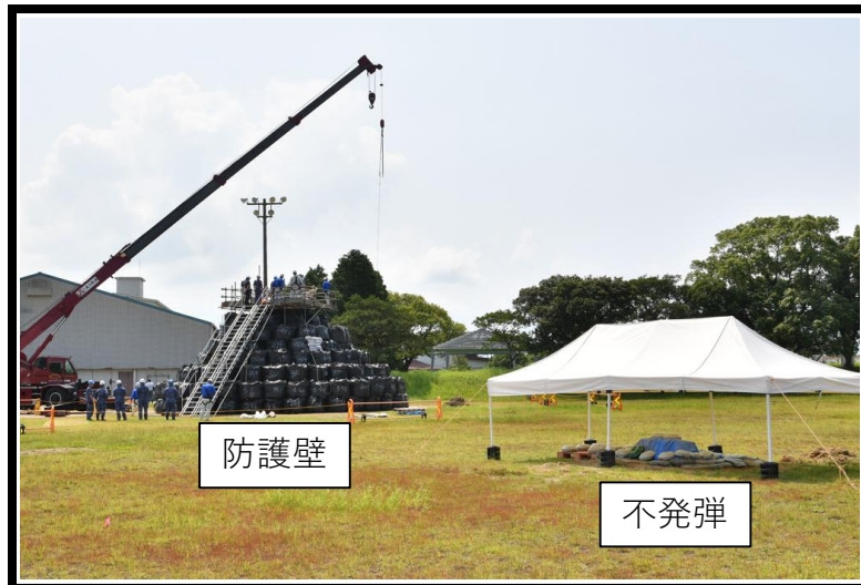
現場の状況①「防護壁と不発弾」
