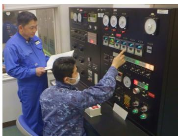
電機計器班は、主に航空機のバッテリー、発電機等の電機系統や、速度計・高度計等の計器系統の機器を整備しています。
