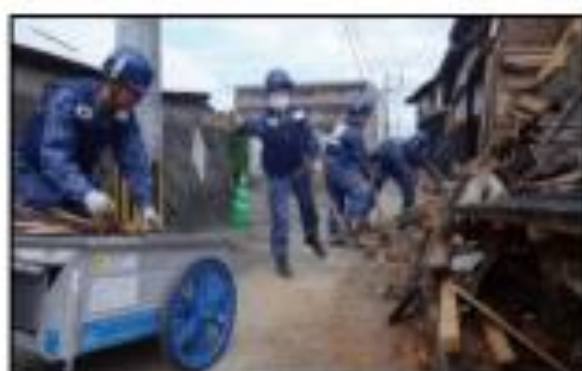
瓦礫などの撤去作業
