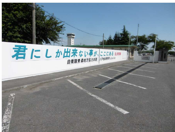
メッセージ設置後の正門
