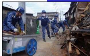
瓦礫などの撤去作業
