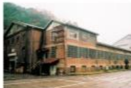
ジャパン・マリンユナイテッド 第2電気工場
