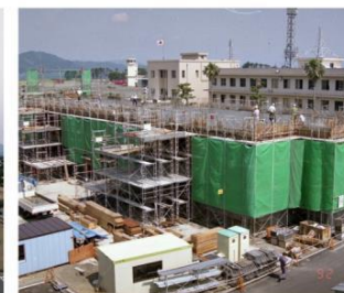
H4.6 建設中の第2隊舎
