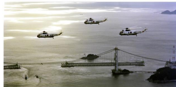
S59. 1 建設中の大鳴門橋上空を飛行するH S S-2
