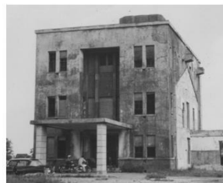
コンクリート製の堅牢な庁舎施設 平成24年まで庁舎として使われた
