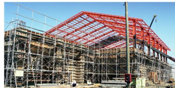
H3.12 建設中の体育館等施設
