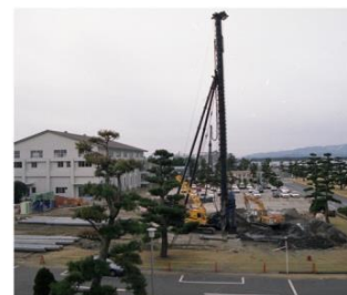
H4.4 建設中の第2隊舎
