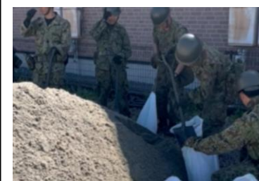
【八代市】ブルーシートを固定する土のうを作成する陸自隊員 ※8/6撮影
