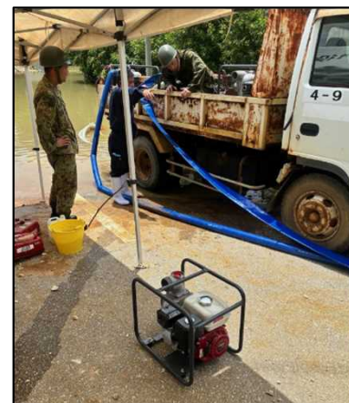
排水作業の様子
